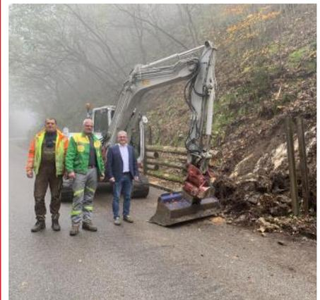
Durch die schon sehr schadhafte Holzbohlenwand und des Auflagesgitters aber auch durch die großflächige Materialverfüllung hinter der Bohlenwand (Sturzauffangbereich) ist die Schutzwirkung nur mehr unzureichend gegeben. Dadurch kam es in der Vergangenheit immer wieder zu Ereignissen durch Loslösung von Gesteinsmaterial, Wurzelwerk und Absturz von umfallenden Bäumen und Astmaterial, was zu Verkehrsbeeinträchtigungen und Störungen im Bereich der Gemeindestraße führte.
